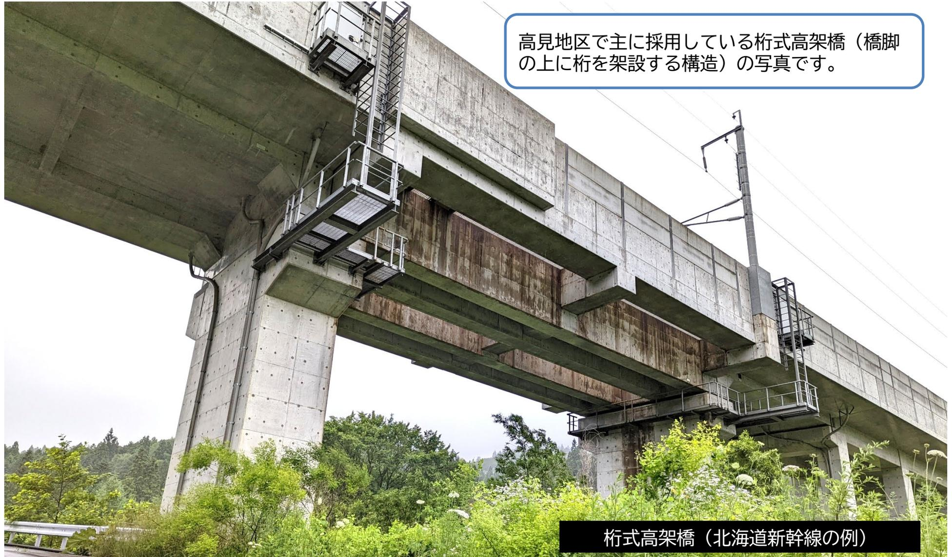
高見地区で主に採用している桁式高架橋（橋脚の上に桁を架設する構造）の写真です。
