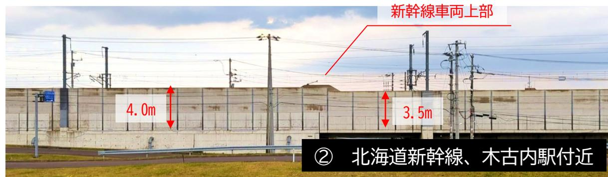
民家が近接する倶知安駅の前後区間では、レールの高さから4.5mの位置まで、防音壁を設置します。防音壁高さが4.5mの区間では、新幹線車両が防音壁に覆われる形となります。
