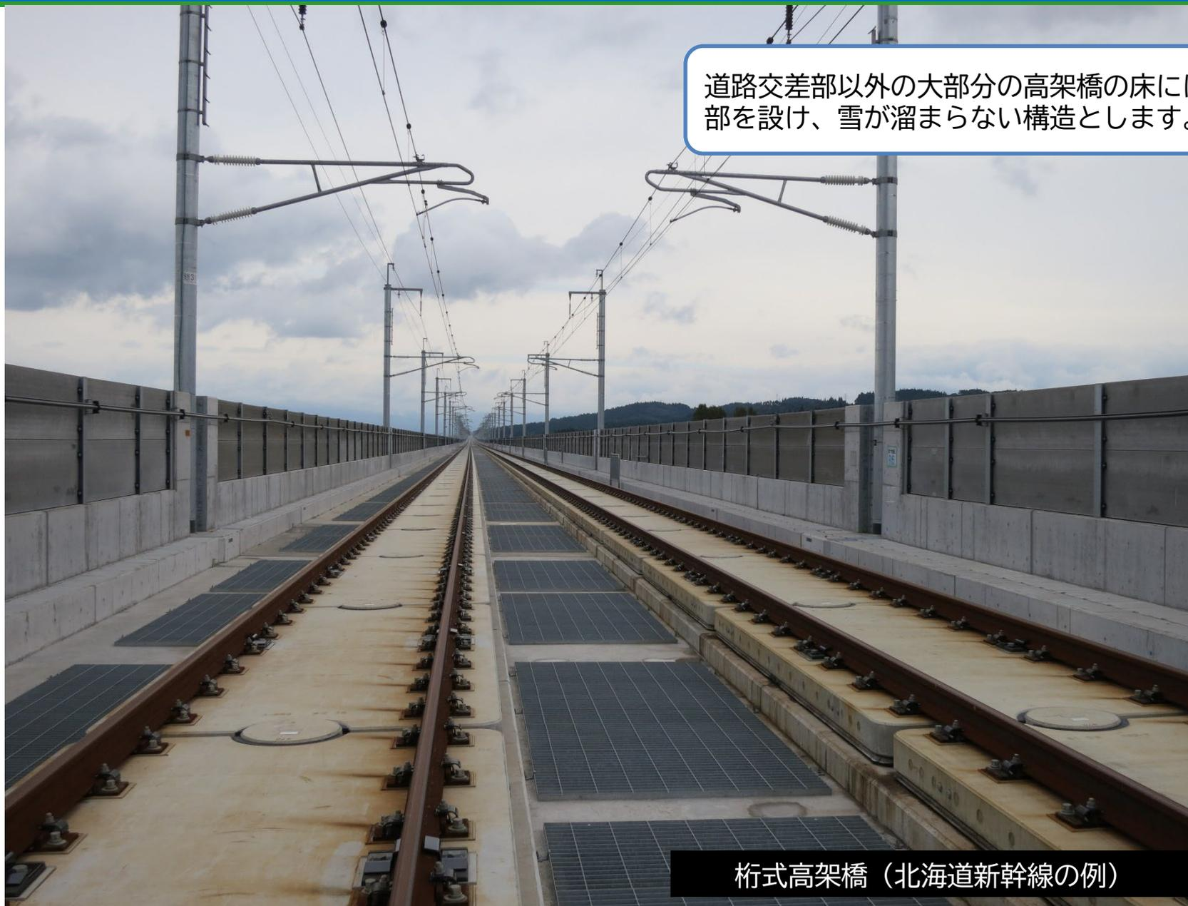
道路交差部以外での大部分の高架橋の床には開口部を設け、雪が溜まらない構造とします。
