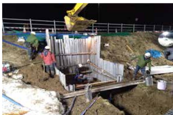
漏水修理緊急工事の様子
