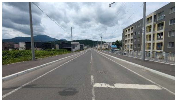
国道との交点より西側・改良工事完了(R6.6)
