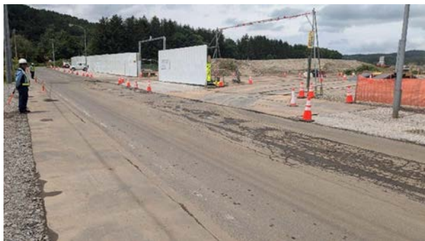
新幹線工事車両出入り(R6.6)
