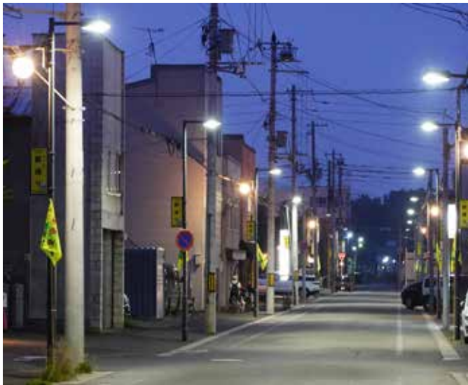
→各町内会で設置、維持管理されている防犯灯
