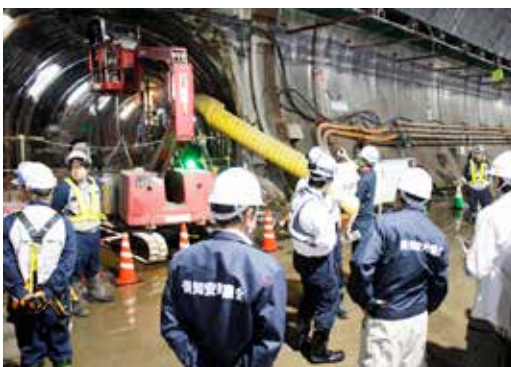
羊蹄トンネルの工事現場
