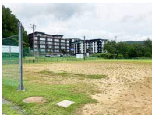
駐車場として舗装予定の多目的広場
