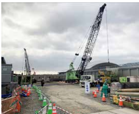
新幹線工事現場（2023年10月時点）
