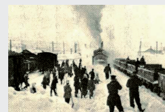
◀ 駅構内の除雪の様子 開業後しばらくは雪害に悩まされ、機関車の遅延や立ち往生があり、冬季は運休が続出していた
