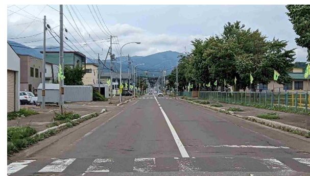
中央線引き直し(令和5年8月撮影)
