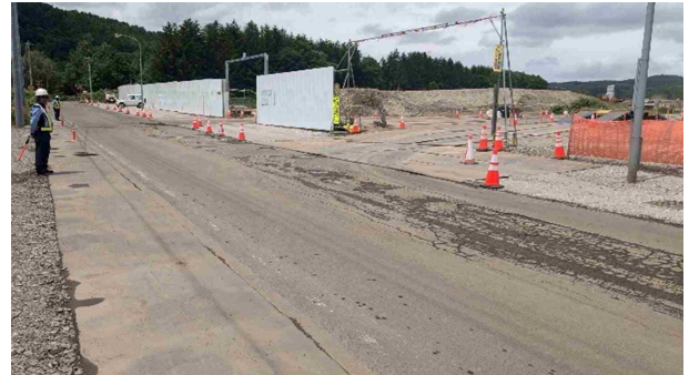
新幹線工事車両出入り(令和6年6月撮影)
