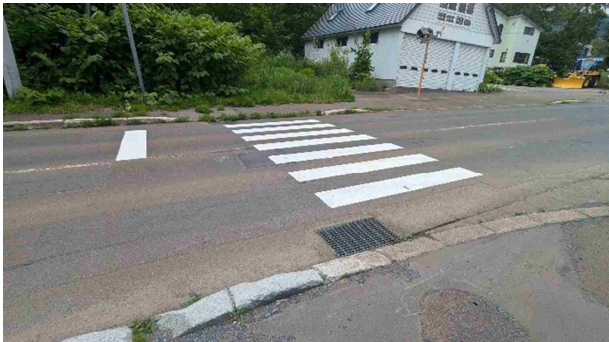
横断歩道塗装(令和 6 年 6 月撮影)
