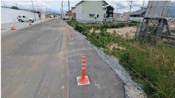
分離ポールコーン設置(令和6年6月撮影)
