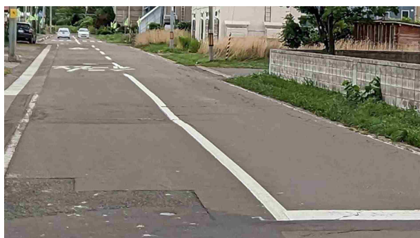
中央線引き直し(令和5年8月撮影)
