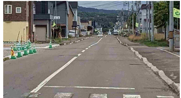
中央線引き直し(令和5年8月撮影)
