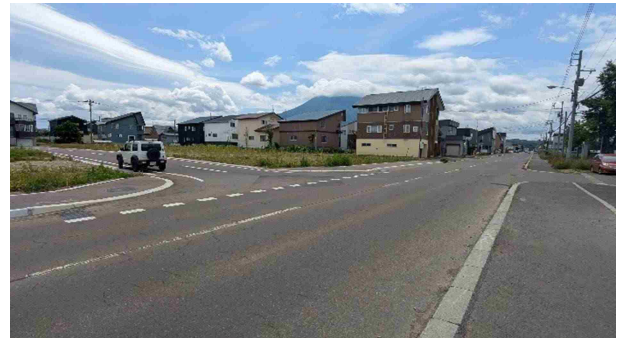
宅地造成部分(令和6年6月撮影)
