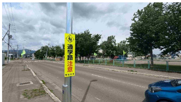
街路灯交換に伴う注意看板設置(令和2年)
