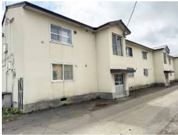
老朽化が進む昭和37年築の職員住宅
