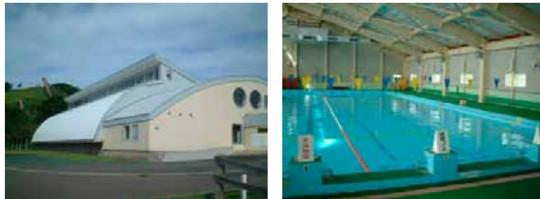
■ 倶知安町青少年センター（昭和 4 2 年竣工：令和 6 年解体）
