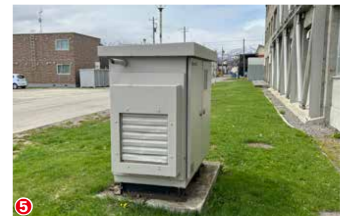
既存施設解体前状況写真
