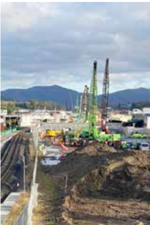
新幹線工事現場
