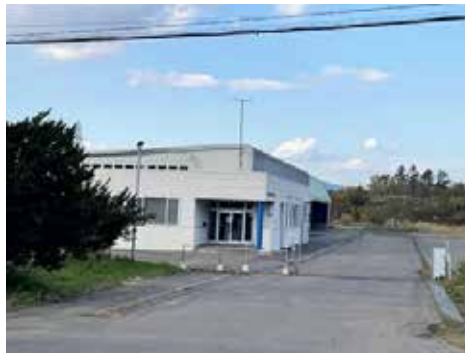
老朽化が懸念される地方卸売市場施設
