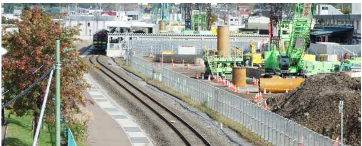
JR在来線（左）と新幹線高架橋工事（右）
