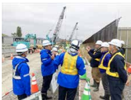
↑ 駅前の杭打ち作業現場
