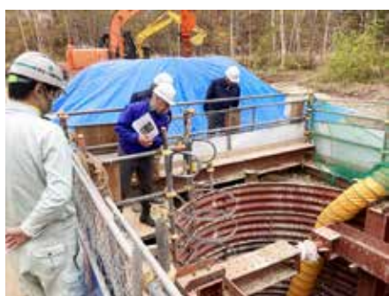
↑ 水道工事現場
