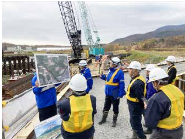
新幹線の工事現場（岩尾別高架橋）
