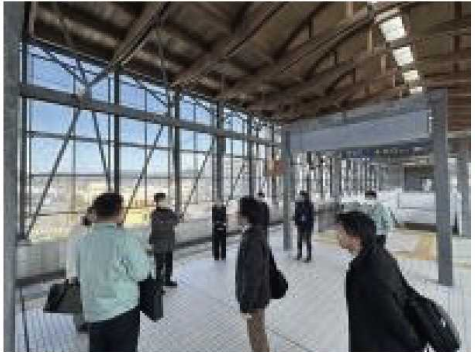
2006年の開業から18年経過した現在でも ほのかに杉の香りがする日向市駅ホーム
