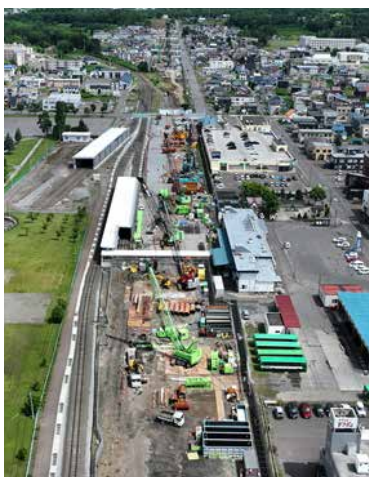
俱知安駅高架橋工事の様子 (鉄道・運輸機構によるドローン撮影)
