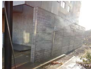
隣地との敷地境界に近い位置に塀を設置
