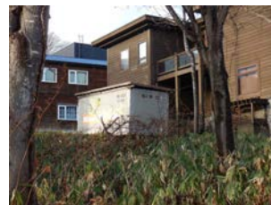
デザインに配慮がなく、道路から見えてしまっている事例
