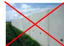
圧迫感のある2m超の垂直擁壁
