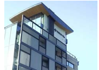
道路からセットバックが望まれる例
