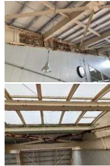
町営プール（内部鉄骨）
