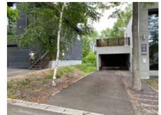
ビルドインタイプのガレージ
