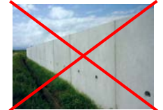
圧迫感のある2m超の垂直擁壁
