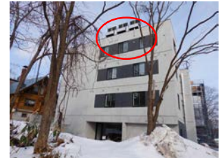
外から丸見えの屋上設置の室外機(現在は対応済み)
