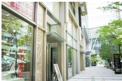
内部の雰囲気を通りへにじみ出すガラス 壁面の間口の建物
