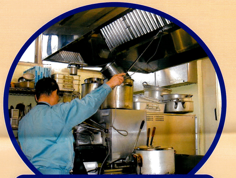
換気設備の風量測定
