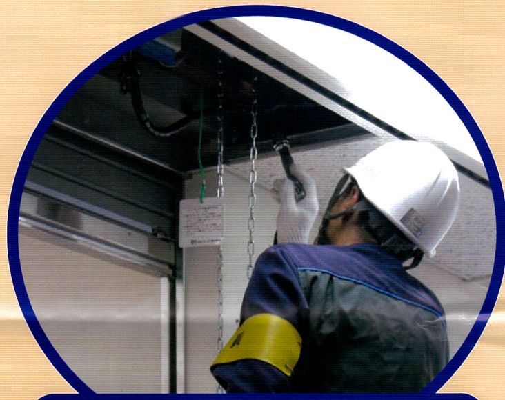
防火設備の駆動装置検査
