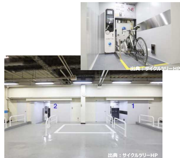
J R 立川駅（屋内駐輪場）
