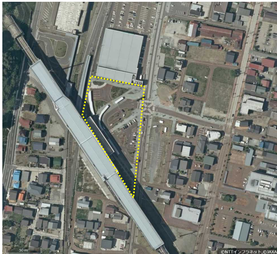
北陸新幹線飯山駅駅前広場（千曲川口） 敷地面積：約8,000m 2
