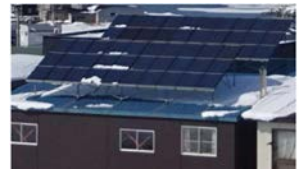
設置の位置などに配慮が求められる 屋上設置の太陽光パネル
