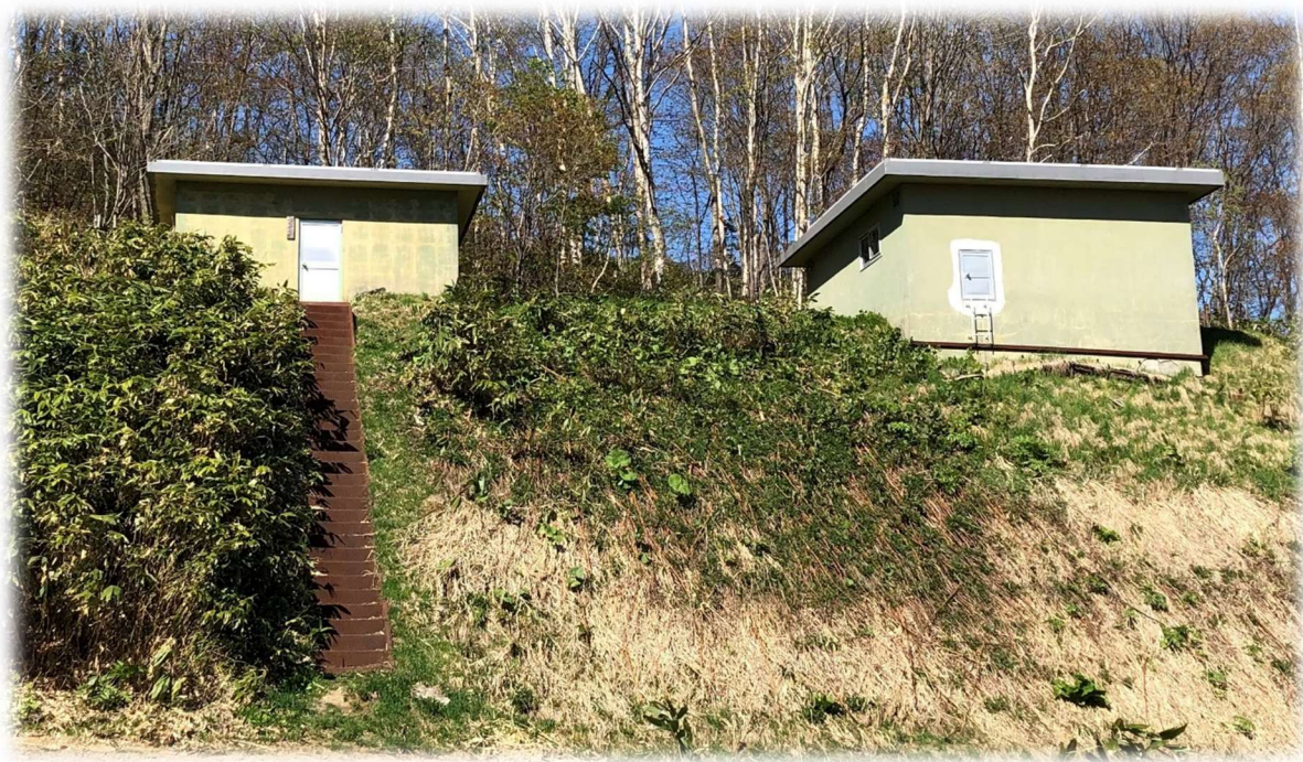
高区配水池（1号・2号）
