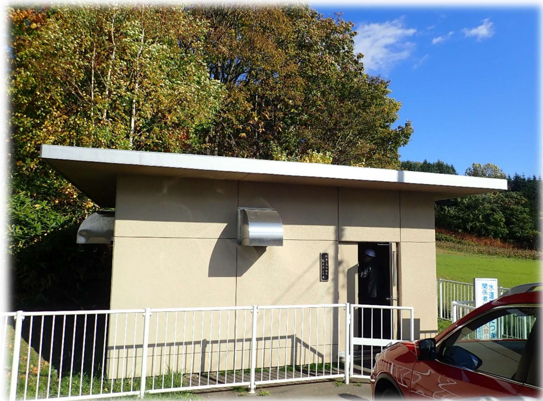
扶桑・大和配水ポンプ場
