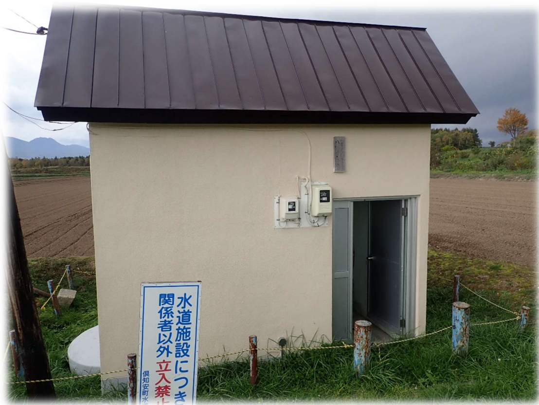
八幡増圧ポンプ場
