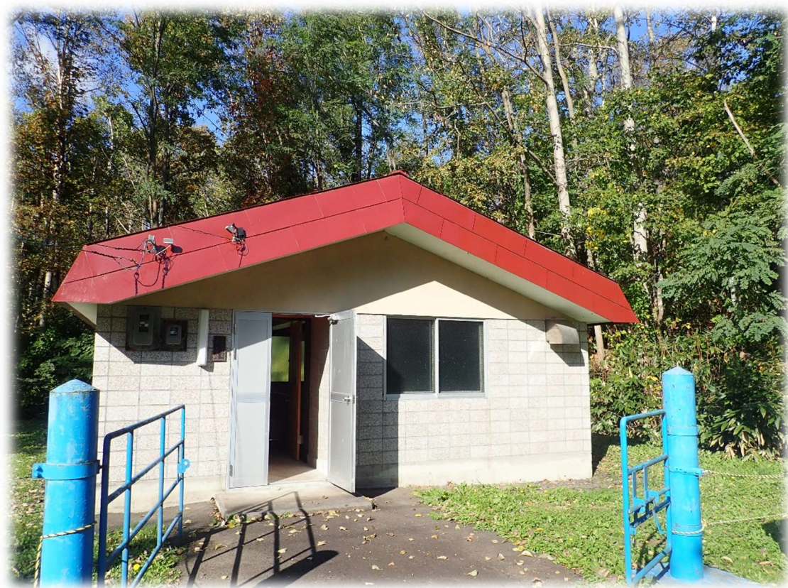
北部高台増圧ポンプ場
