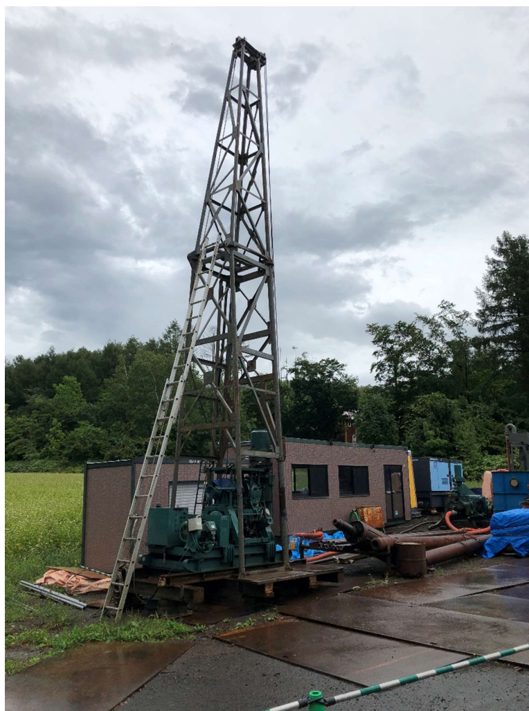
井戸掘削の様子
