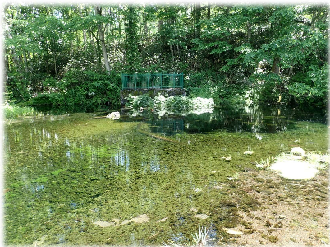
高砂水源地（第3取水枠）
