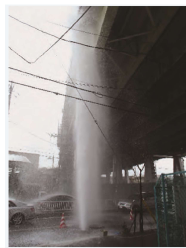
水道管の老朽化による漏水の発生 (出典：土木学会)
