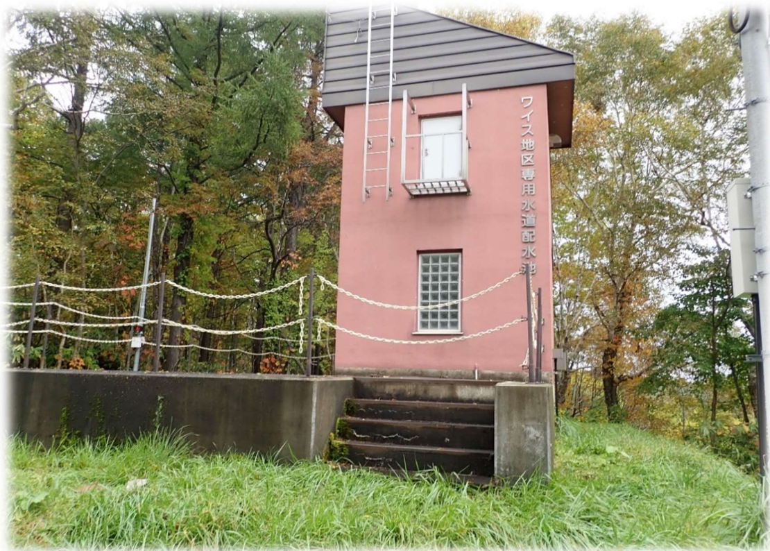
ワイス配水池
