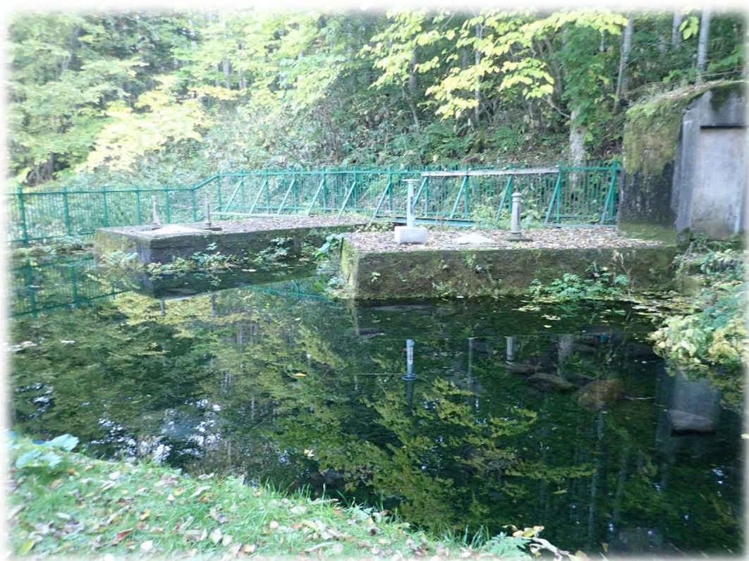
高砂水源地（第1・第2取水枠）
