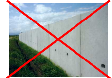
圧迫感のある2m超の垂直擁壁
