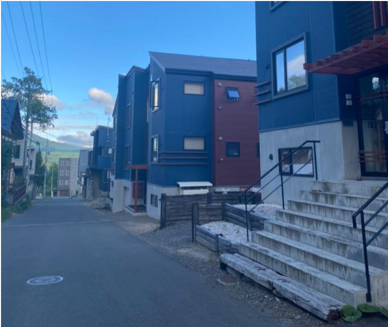
道路からの後退距離が少なく、緑地が設けられていない事例。
