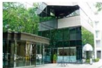
建物の中央部をセットバックし、ケヤキ並木への配慮とともに壁面を隠行させた建築物
