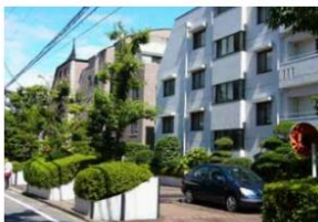
駐車場の路面の舗装を工夫し、周囲を緑化している例
