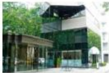
建物の中央部をセットバックし、クヤキ並木への配慮とともに壁面を露行させた建築物 「定禅寺通街並み形成ガイドライン」より
