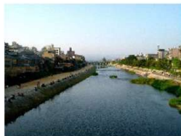
□ 地域の景観の骨格として、自然景観に調和した河川整備 (鴨川 (京都府 京都市))
