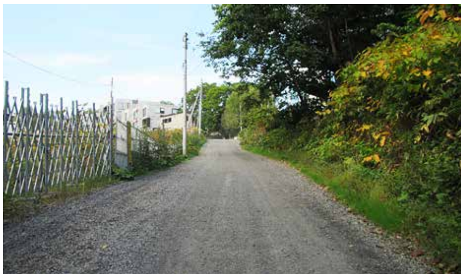
仮にロードヒーティング施工だと工事費や用地費を含め12億程の試算結果
