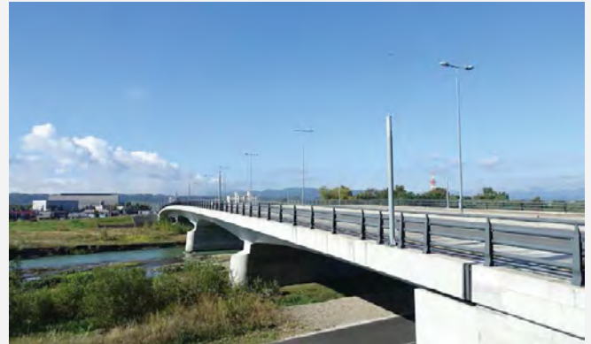
旭川市; 北彩都地区 クリスタル橋(昭和通) 歩道用照明柱・標識柱 ※先の永隆橋通の「青緑みのグレー(10BG5/2)」よりも彩度が抑えられている。高欄は暗めの5B3/1。
