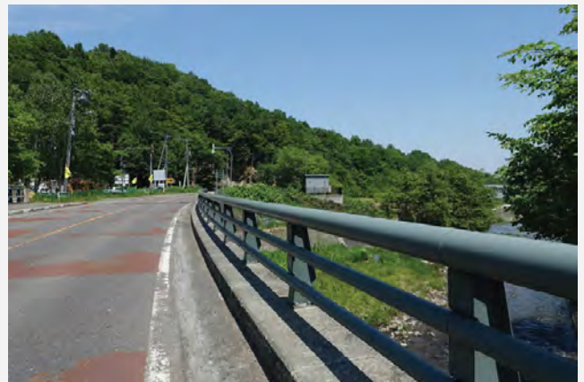
札幌市常磐; R453 橋梁用防護欄
