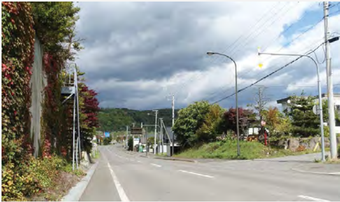
愛別町; 道道140号の照明柱
