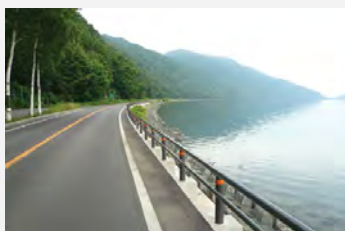
R453 支笏湖畔 (ガードパイプ)
