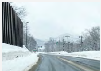
R230 定山溪 (照明柱)
