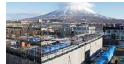
▲役場庁舎2階部分の建設工事が進む （3月16日現庁舎3階から撮影）
