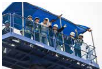
▲高所作業車で約15mの高さまで上昇（余市町登川大橋工事現場）
