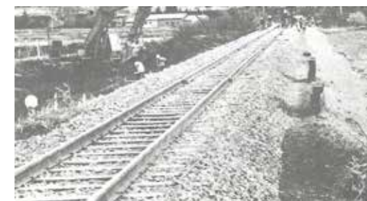
復旧後の左の写真の地点（昭和56年10月29日）
