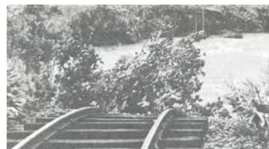
旧胆振線の線路が流失（昭和56年8月23日）
