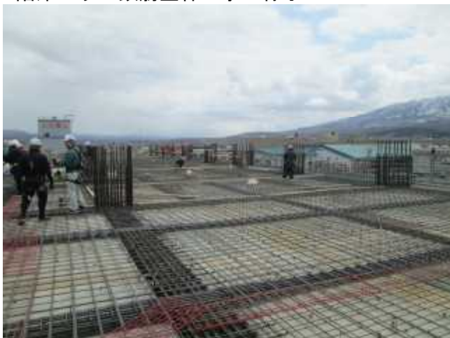
3階床スラブ鉄筋型枠工事の様子
