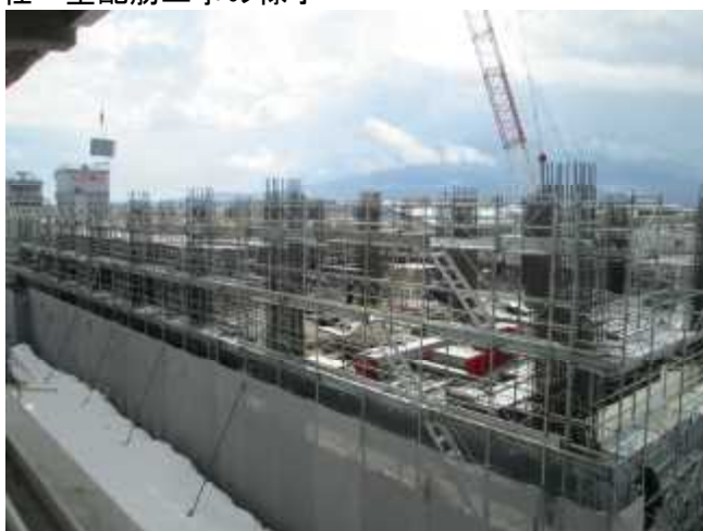
柱・壁配筋工事の様子
