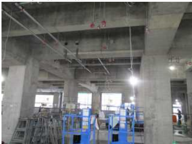
配管工事の様子(1階)
