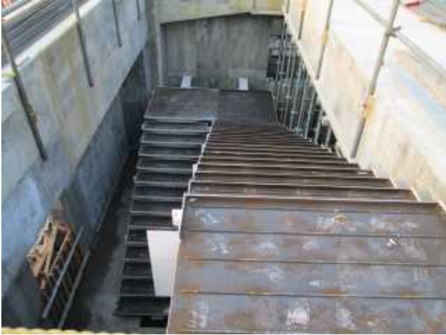
設置された鉄骨階段(1階-2階)
