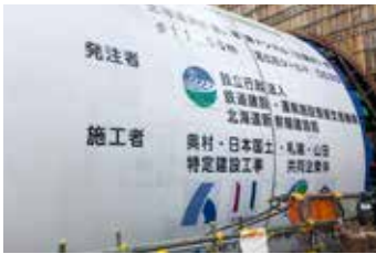
▲シールドマシンの全体（左）と先端部分（右）
