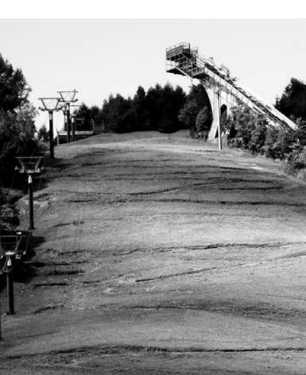
旭ヶ丘公園「フロートレイル実証実験コース」
