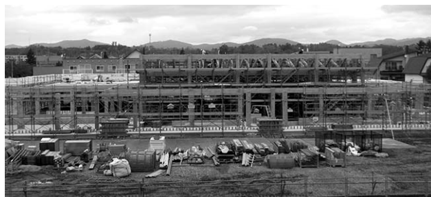
4月開所に向けて建設中の統合保育所（南3東5）
