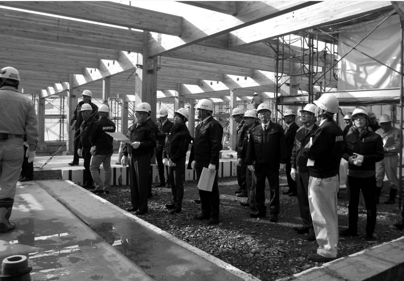
建設中の統合保育所の視察
