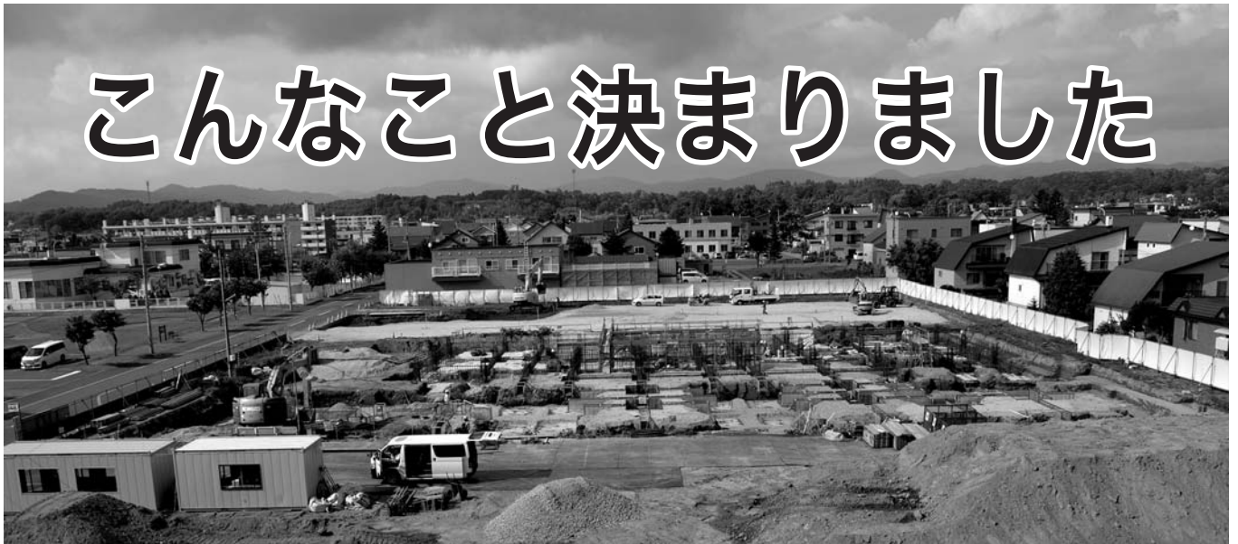
建設が進む統合保育所（南3条東5丁目）
