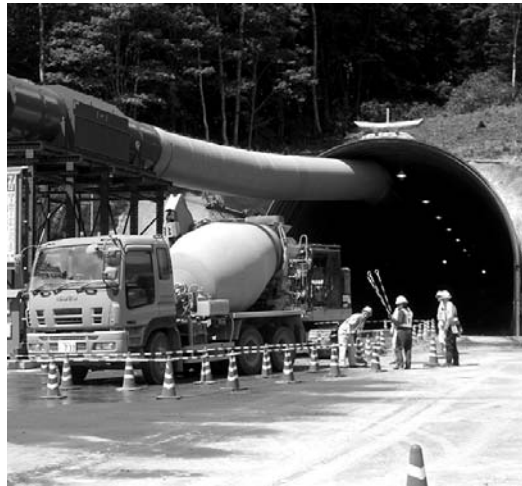
切削工事が始まったニツ森トンネル（鹿子地区）
