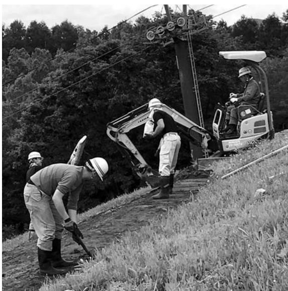
旭ヶ丘公園園路修復（直営）
