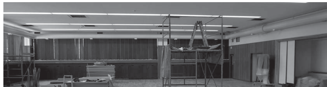
俱知安中学校 格技場吊天井耐震改修
