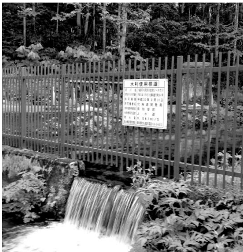
高砂地区水資源保全地域の高砂水源地
