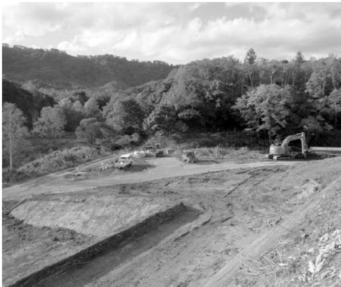
二ツ森トンネル工事作業風景
