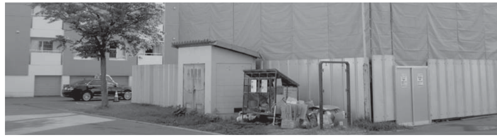
羊蹄団地5号棟 長寿命化工事中
