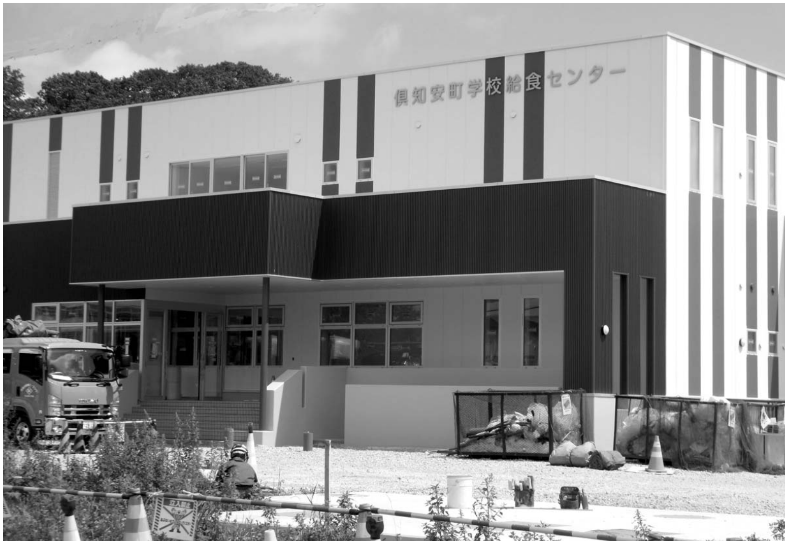
～建設中の学校給食センター～
