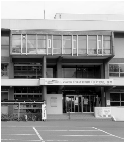
老朽化している役場庁舎
