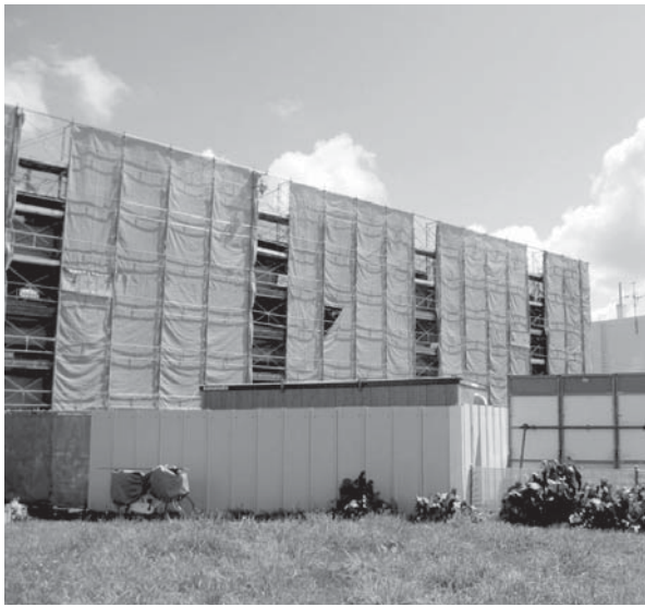
羊蹄団地4号棟 長寿命化工事中
