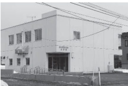
↓分庁舎の建物
