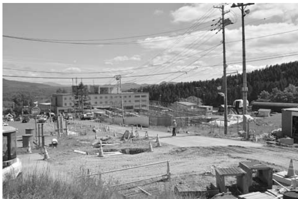
▲自然景観に配慮し、魅力的な空間を確保するため、現在、様々な工事が行われている。
