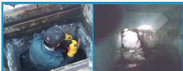
▲壁にこびりついた氷塊をハンマーとタガネで砕いている様子
