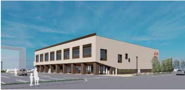
新プール・絵本館の外観イメージ。利用しやすい運営が求められる
