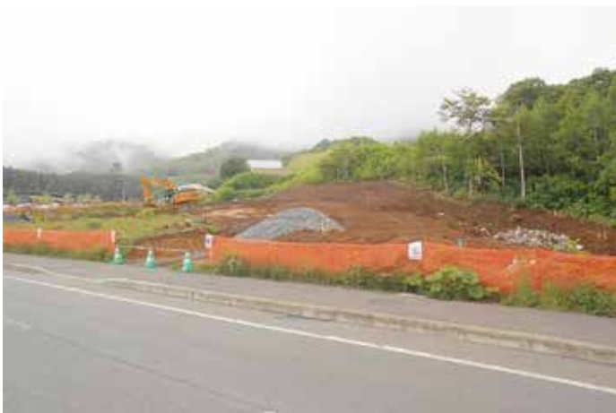
ひらふ高原中央公園の駐車場整備工事現場 (令和8年6月9日撮影)
