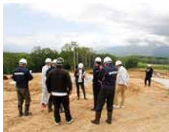
花園ヴィレッジ工事現場
