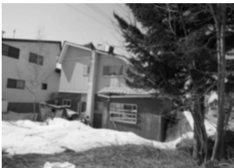
煙突が折れ、下屋が崩壊している空き家
